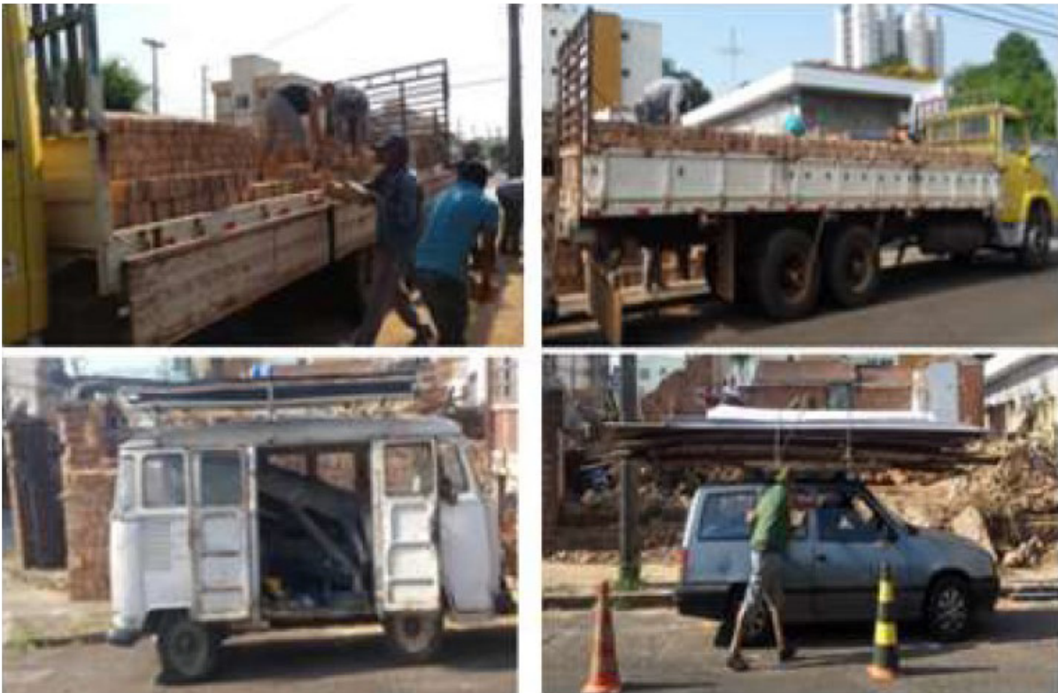
Figura 4 – Revenda dos materiais e componentes de construção em obra.
