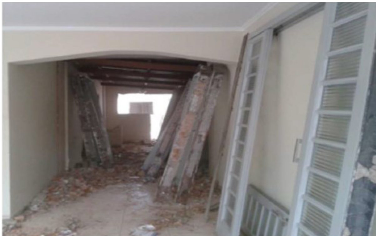
Figura 2 – Recuperação de portas e janelas pela demolição seletiva
