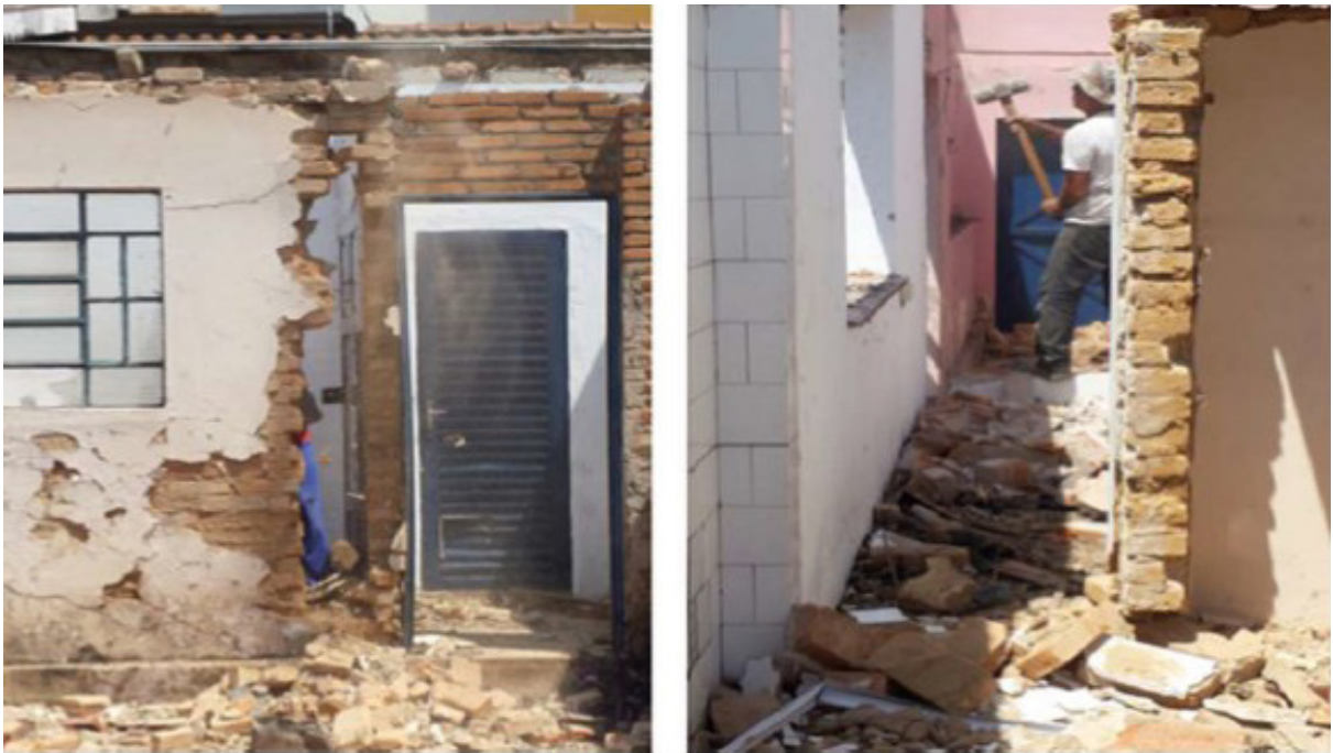
Figura 3 – Demolição manual das paredes exteriores
